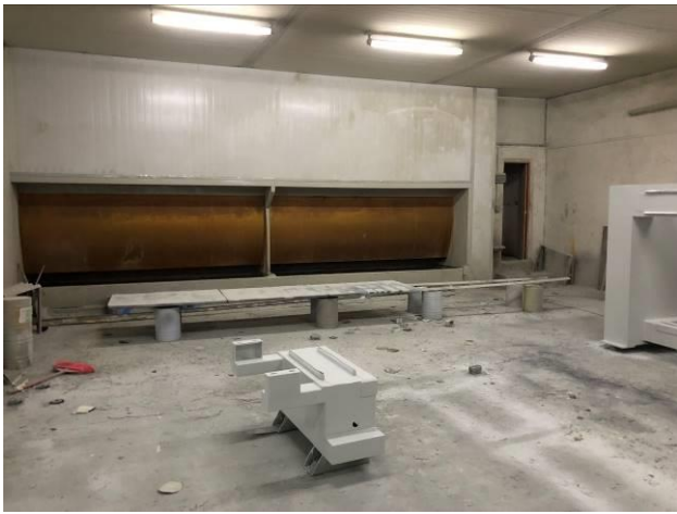
图 3-4e 项目设备（喷漆房）
